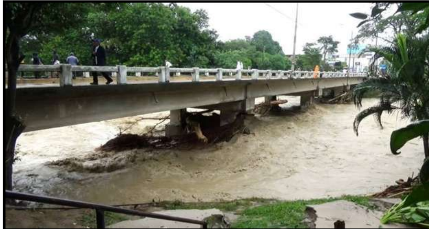
FOTOGRAFIA N°02: AFECTACIÓN A ESTRIBOS DEL PUENTE CUMBAZA
